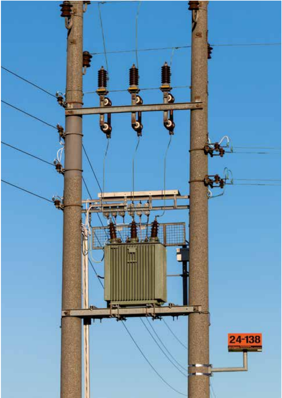
Grosse Unterschiede in der Infrastruktur wichtiger Energieträger: Lediglich eine schlichte Standorttafel weist auf die Erdgas- und Biogas-Leitung hin.
